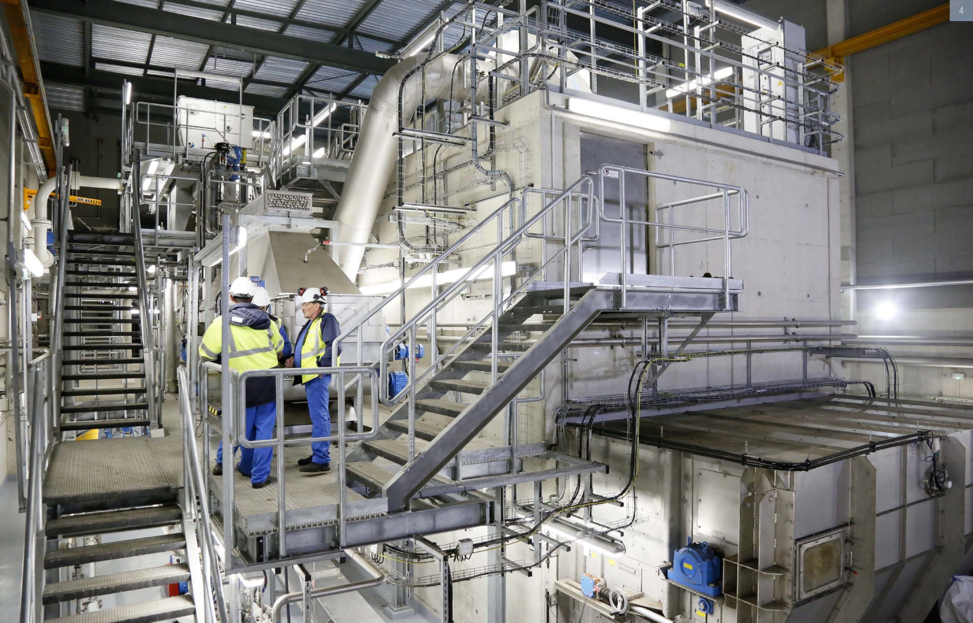
équipe maintenance qui suit le séchage thermique de l'usine Seine Grésillons du SIAAP, novembre 2015 / Pour Anatome
